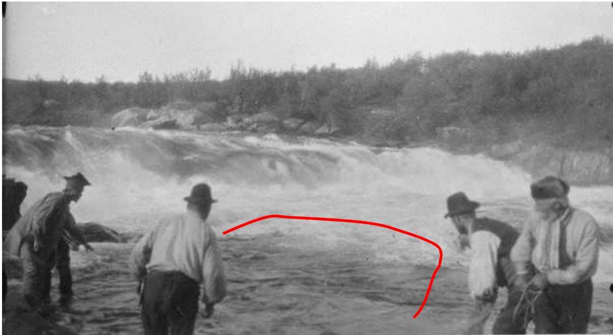
Foto 9. K p l kasting i Skoltefossen den 6. august 1902. Her kastes nota fra "kasteberget til str mvirvelen" (se foto 8) f r betongplattformen ble bygd. Den r de streken markerer den str mvirvelen som nota ble kastet i. "Linkka" p  foto 8 er fossefallet  verst p  bildet. Museiverket SUK bilde 1:27.
